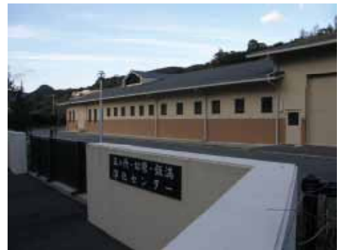
五ヶ所・切原・飯満浄化センター
