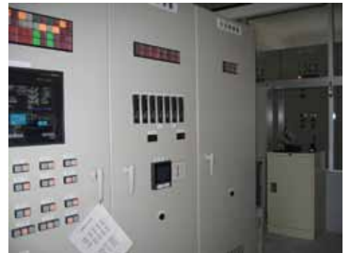
穂原浄水場 計装盤
