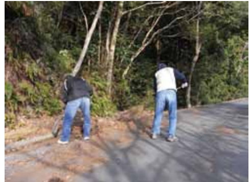
林道監視員の林道整備作業
