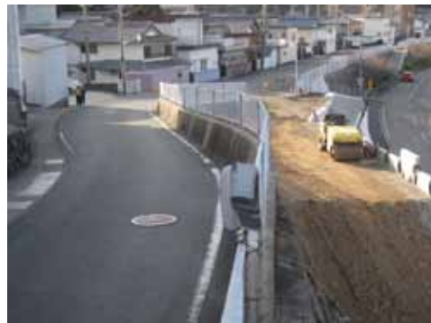
町道田曾浦・宿浦線改良工事
