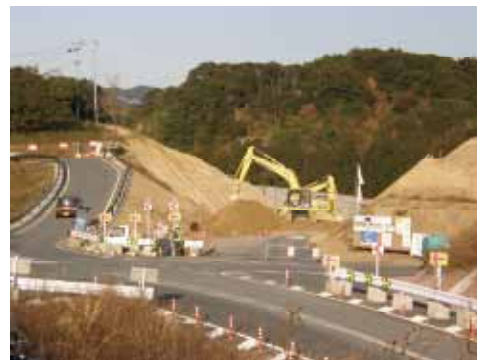
国道 260 号（木谷工区）道路改良工事
