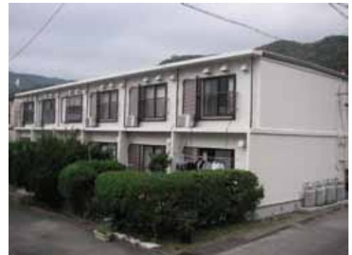
町営住宅 黒潮団地
