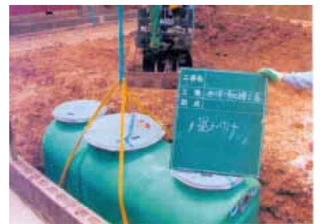
合併浄化槽埋設工事
